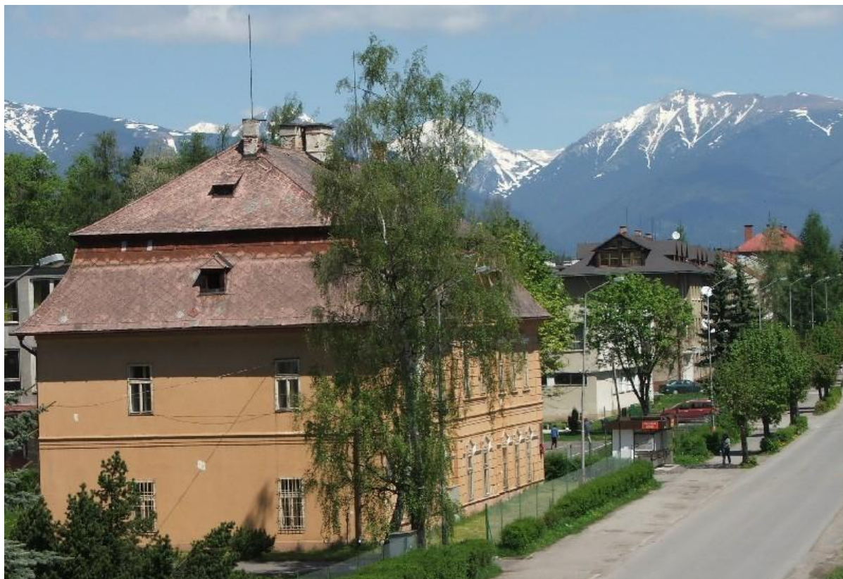
Obr. 4. Druhá budova lesníckej - Horárskej školy v Liptovskom Hrádku
